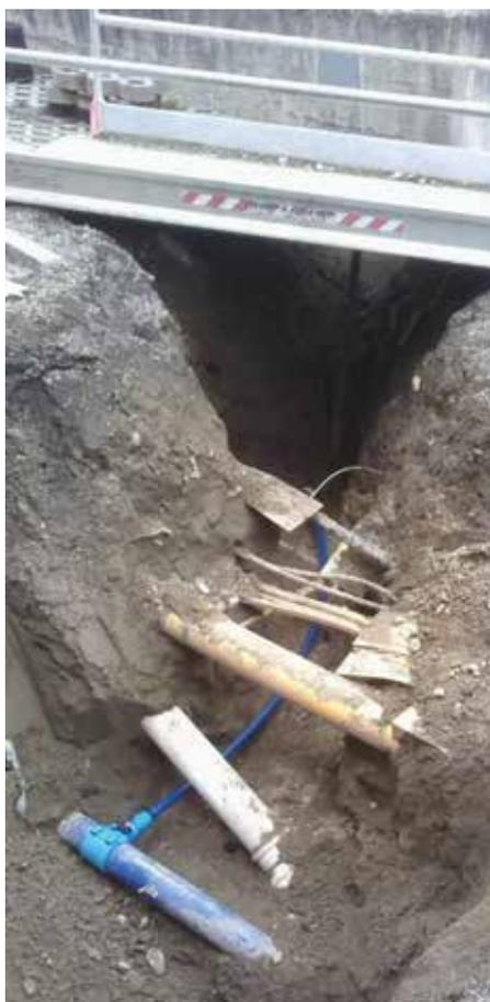
Wasserhausanschluss unterquert Kanal, Gasleitung, LWL-Leerrohre und Kabel. Für die Zugänglichkeit des Wohnhauses wurde eine provisorische Fußgängerbrücke installiert
