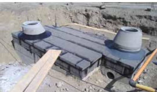
Mischwasserüberlaufbauwerk nach der Isolierung. Die dortige Gasleitung musste umgelegt werden
