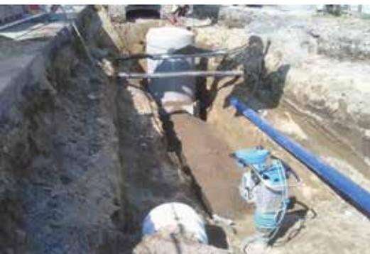
Mehrfach-Rohrgraben: Obergasser Bach, Mischwasserkanal, Wasserleitung (v. li.)
