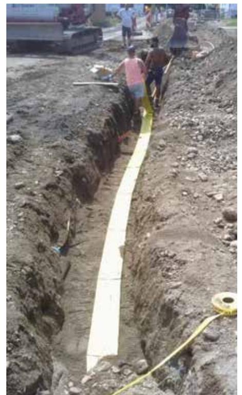
Kabel und LWL-Leerschläucher werden mit Abdeckplatten und Warnband vor Beschädigungen bei späteren Grabungsarbeiten geschützt
