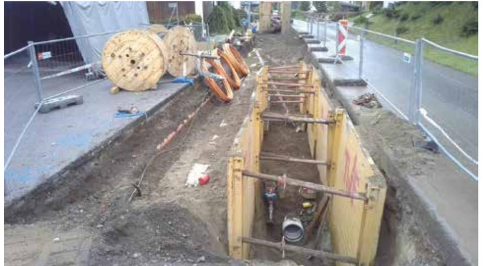
2 Kanal- und Wasserleitungsbau mit Breitbandausbau in der Landesstraße
