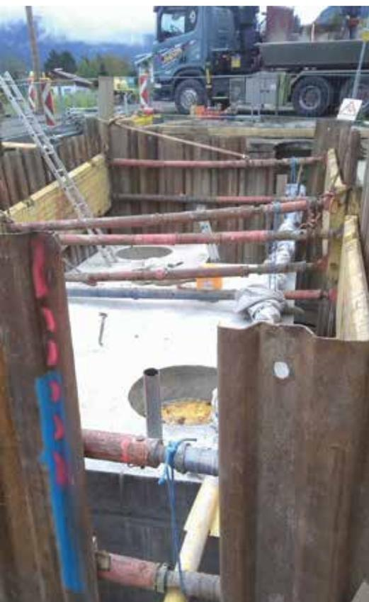
4 Für die sehr tiefe Baugrube des Mischwasserentlastungsbauwerkes war eine spezielle Baugrubensicherung, ein Kammerdielenverbau, erforderlich
