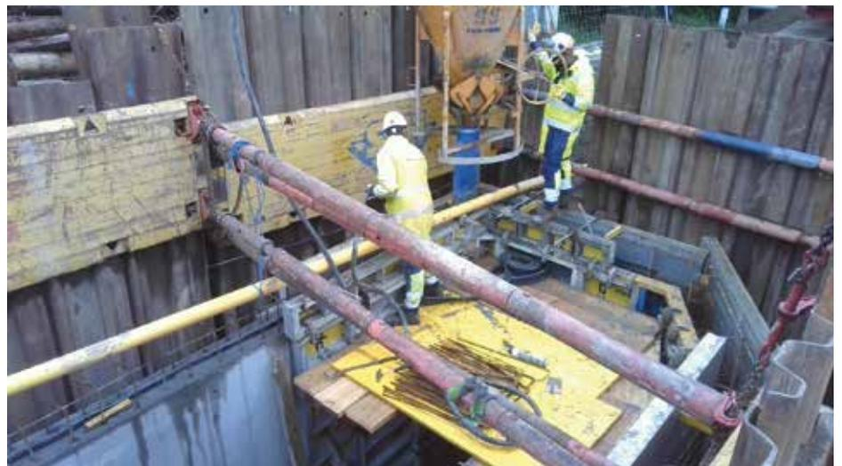
3 Die Wände des Mischwasserentlastungsbauwerkes werden mit abwasserbeständigem Beton hergestellt
