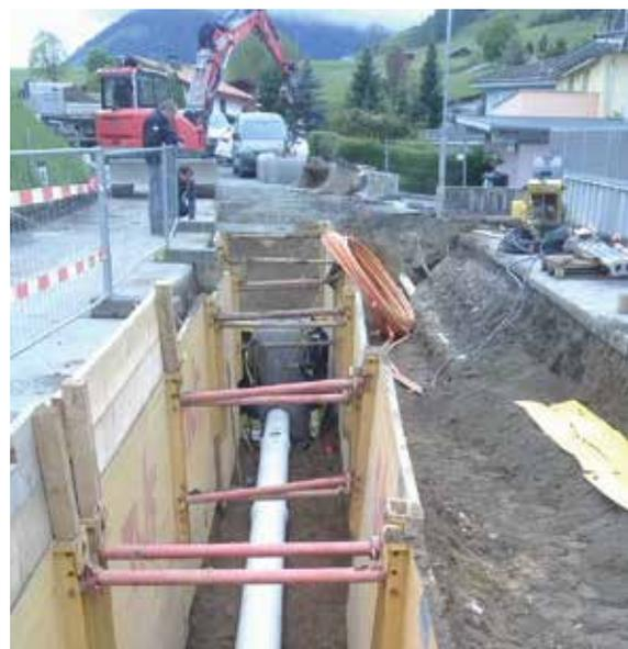
5 Neben dem Mischwasserkanal wird die Hauptwasserleitung erneuert. Im Hintergrund sind die gelben LWL-Leerrohre und das neue Straßenbeleuchtungskabel zu sehen
