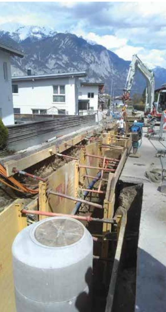
1 Mischwasserkanal, Wasserleitung, LWL-Leerrohre und StraÙebeleuchtungskabel in der Landesstraße
