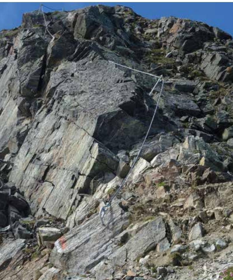
teilung der BH für die Genehmigung und sieben begeisterte Alpinisten aus Oberperfuss. Das verzinkte Material mit rund 21m Drahtseil sowie der Spezialkleber von der Firma HZI aus Arzl/Pitztal musste mühsam hinaufgetragen werden. Die Befestigung des Seilgeländers erfolgte mit 2 Akku-Bohrer, allerdings reichten für die sieben Bohrlöcher in den harten Fels 3 Akkus nicht aus, sodass noch ein 3. Tag notwendig war, damit die Seilversicherung auch künftig allen Wetterkapriolen standhält.
