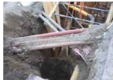
Das dichte Netz an Fremdleitungen machte sogar den Einsatz eines Saugbaggers erforderlich
