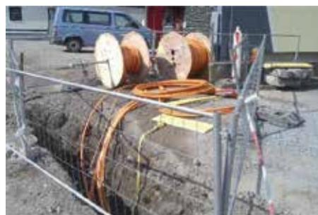
Mehrfachleerrohre für den Breitbandausbau
