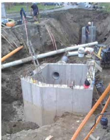
Das neue Mischwasserentlastungsbauwerk drosselt den Mischwasserdurchfluss durch unser Dorf
